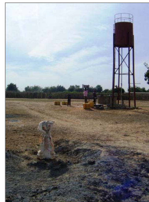
Depósito junto a la perforación
