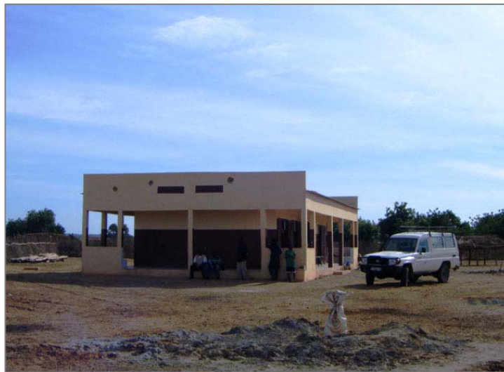
Maternidad junto la perforación
