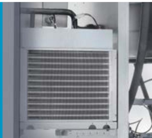
O GA 5-37 VSD<sup>s</sup> com secador incorporado e filtro UD+ está em conformidade com a norma ISO 8573-1, Classe de qualidade 1.4.2.
