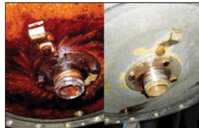
Загрязнение крышки баллона
