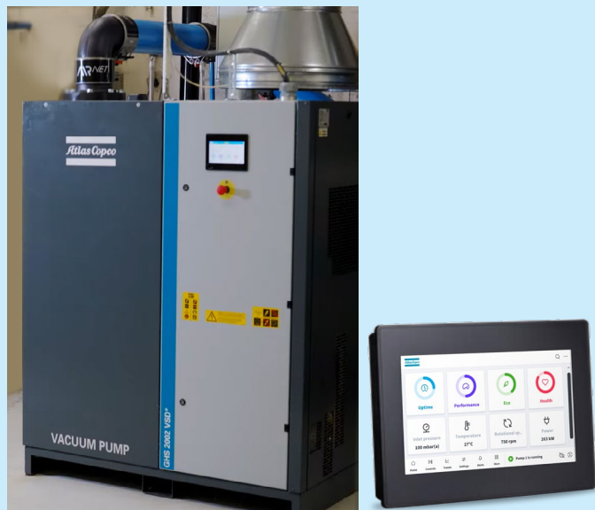
Śrubowa pompa próżniowa z uszczelnieniem olejowym GHS 2002 VSD + firmy Atlas Copco i sterownik HEX@™
