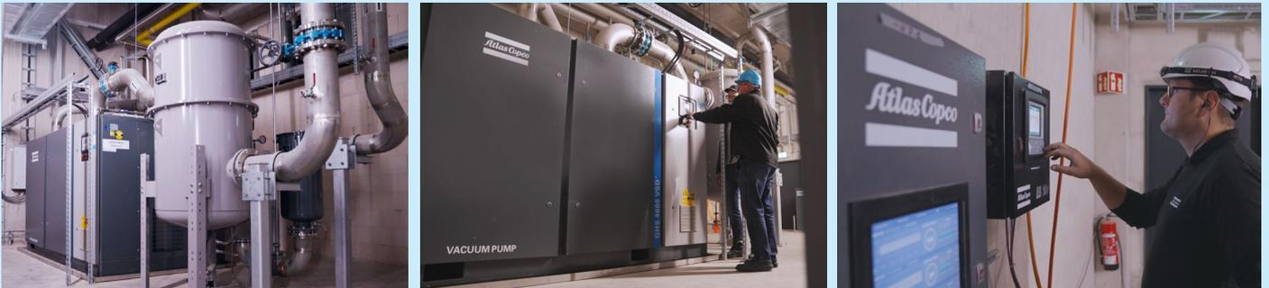
El controlador central ES16 de Atlas Copco puede monitorizar y controlar varias bombas de vacío GHS VSD+ simultáneamente. El sistema de control inteligente equilibra y optimiza el rendimiento de todas las máquinas, reduciendo el consumo de energía total.
