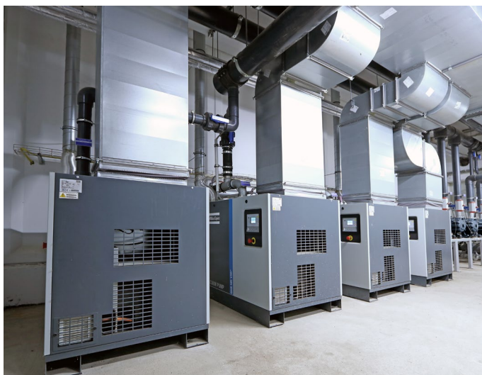
Śrubowe pompy próżniowe z uszczelnieniem olejowym GHS VSD + firmy Atlas Copco
