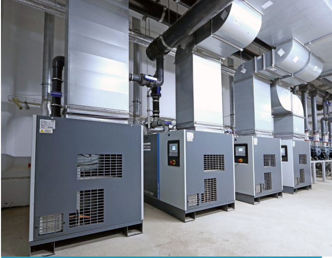
Atlas Copco GHS VSD+ yağ sızdırmaz vidalı vakum pompaları
